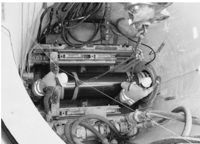
Startgrube: In der Startgrube werden die Rohre vor der Pressmaschine „eingefädelt“.
