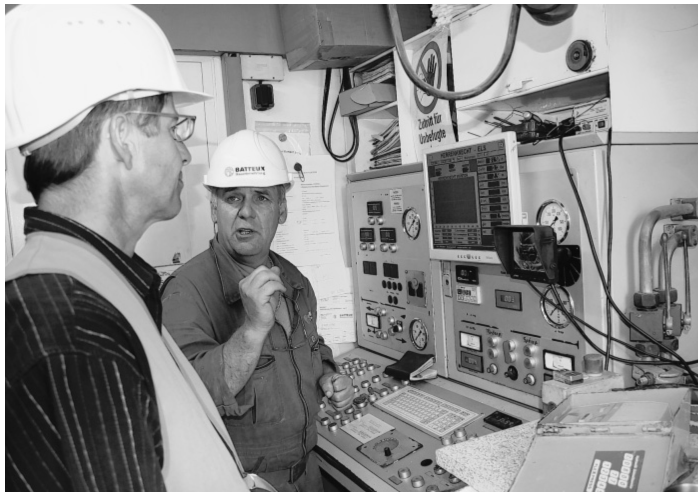
Bohrsteuerung: Im Kontrollraum neben der Startgrube steuert Karl-Ludwig Rausch (Mitte) von der Firma Batteux die Bohrung. Michael Schumacher (l.) vom Eigenbetrieb Abwasser überzeugt sich davon, dass die Leitung auf Kurs bleibt.
