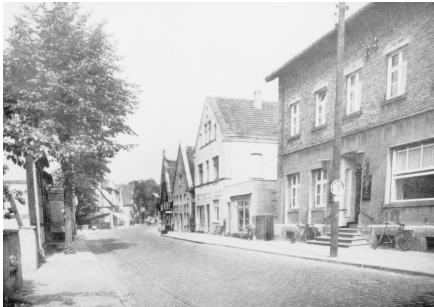
Als die Berliner Straße in Rheda noch Lange Straße hieß: Das Restaurant „Zum Stadttor“, geführt von Conrad Schmits, wurde vor rund 40 Jahren geschlossen. Im Sommer 2011 wich das Gebäude dem Neubau eines Wohnhauses. FOTO: ARCHIV JOCHEN SÄNGER
