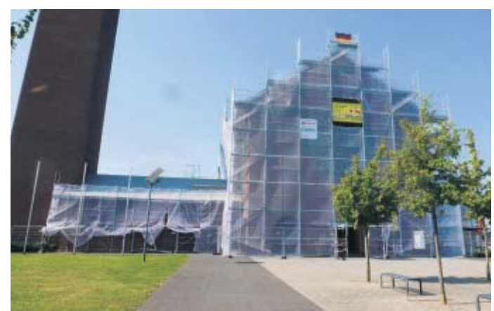
Die Piuskirche trägt einen Schleier: Das Schieferdach muss nach einem Hagelschaden erneuert werden. FOTO: WILHELM IDE
