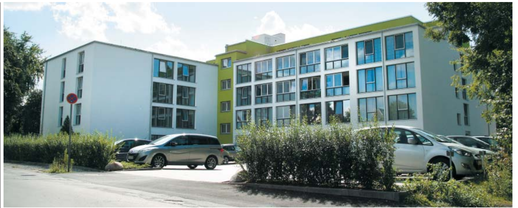
Teurer als geplant: Der Umbau des 1975 errichteten, ehemaligen evangelischen Altenheims an der Parkstraße 1 in seniorengerechte Wohnungen hat fast drei Millionen Euro mehr gekostet als zuvor kalkuliert worden war. FOTO: MARION POKORRA-BROCKSCHMIDT
