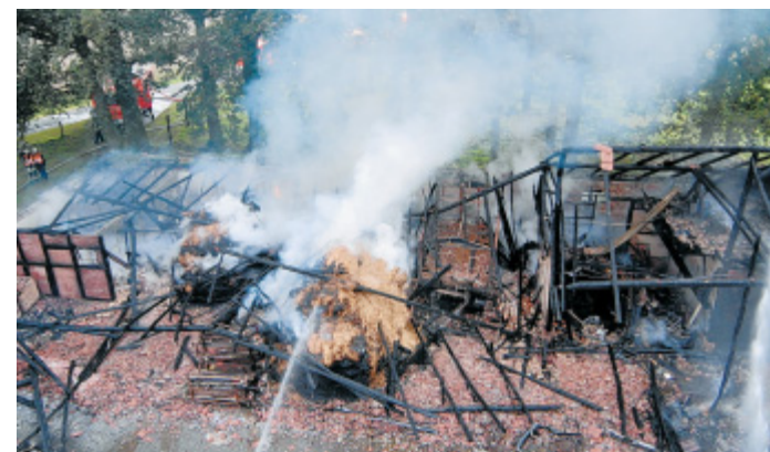
Zerstört: Die Dachbalken über der Stallung sind eingestürzt, aus dem dort gelagerten Stroh qualmt es.
