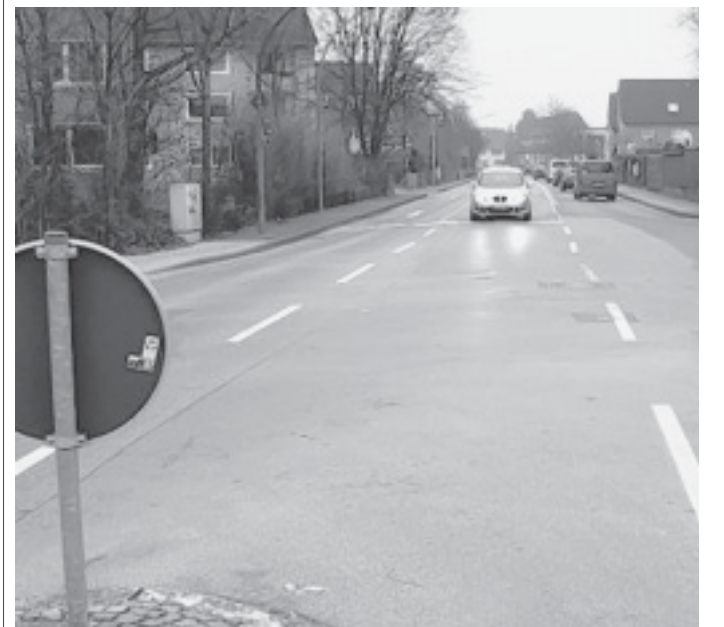
Rohre marode: Die Abwasserkanäle unter dem Nordring (hier von der Kreuzung Sandberg aus gesehen) werden im Sommer erneuert. Während der Arbeiten wird die Straße gesperrt und der Verkehr umgeleitet.
