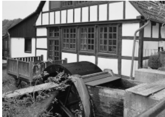
Innovativ: Das Wasserrad an der Seite des Hauses wird vom Furlbach angetrieben und erzeugt umweltfreundlichen Strom.
