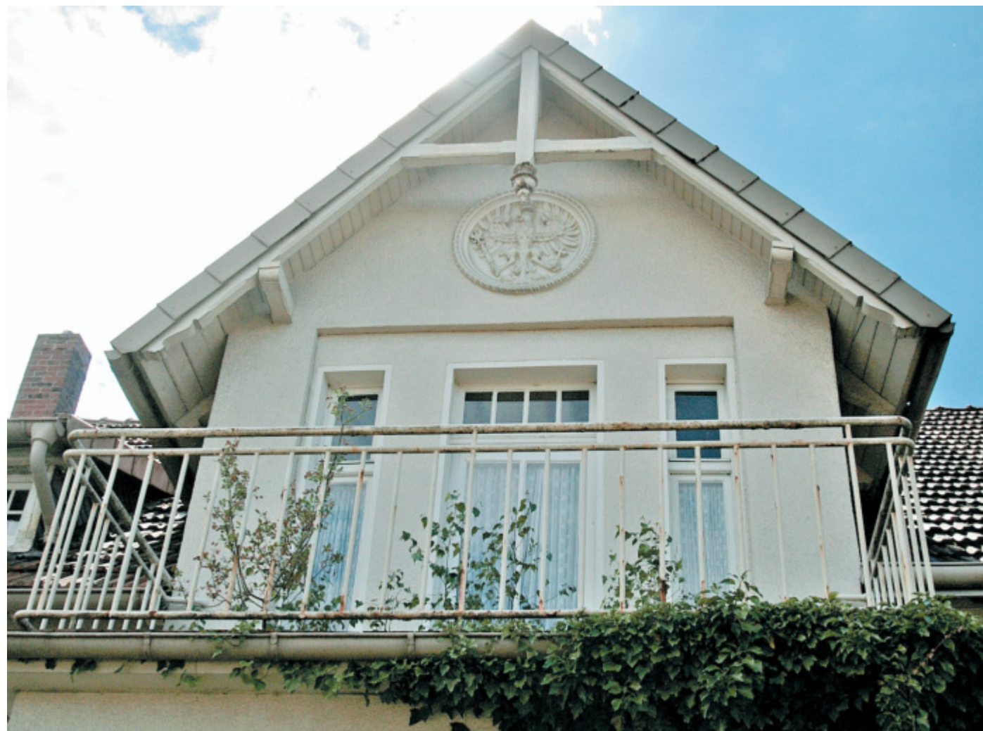
Das Emblem soll gesichert werden: Um die Erinnerung an die alte Post-Villa zu bewahren, wurde im Bauausschuss vorgeschlagen, den preußischen Adler vor dem Abriss des Gebäudes zu erhalten und später dem Neubau zuzuordnen.
